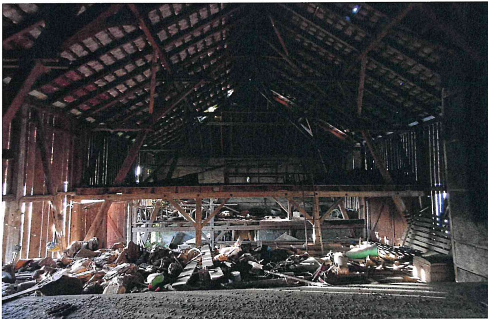
Abb. 5: Die Scheunen (innen wie außen) wurden detailliert inspiziert (mit Wärmebildkamera, Endoskop, Drohne, Fernglas usw.).
