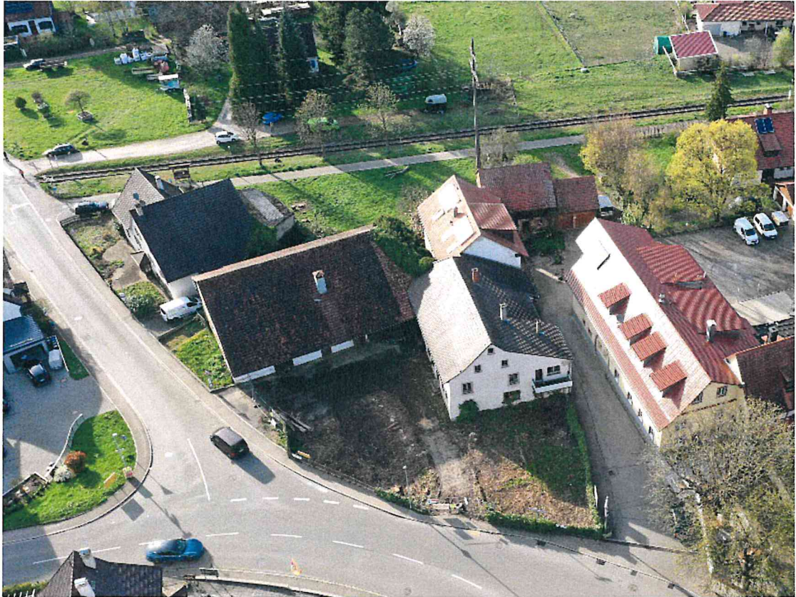
Abb. 4 Blick von Osten; Befliegung am 18.4.2022, Aufnahme zur Verfügung gestellt von H. Müller-Stieß
