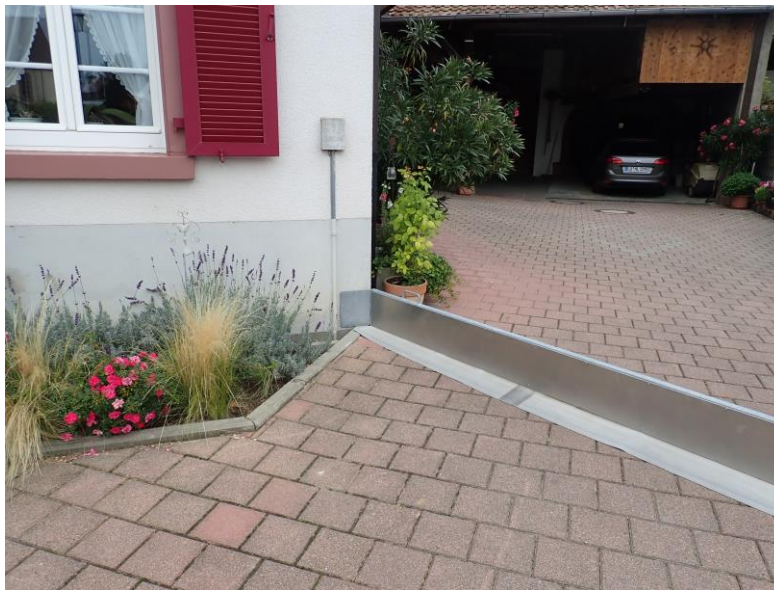
Abb. 58: Mobile Schutzeinrichtung in Schallbach als Eigenvorsorge (Foto: Jessica Kempf)
