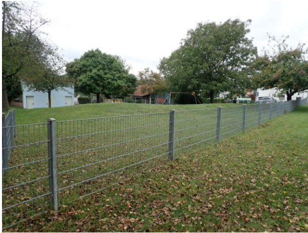
Abb. 54: Verwallung am Kindergarten in Wintersweiler (Foto: Jessica Kempf)
