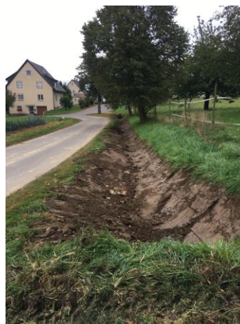
Abb. 53: Grabenerneuerung in Schallbach (Foto: Jessica Kempf)
