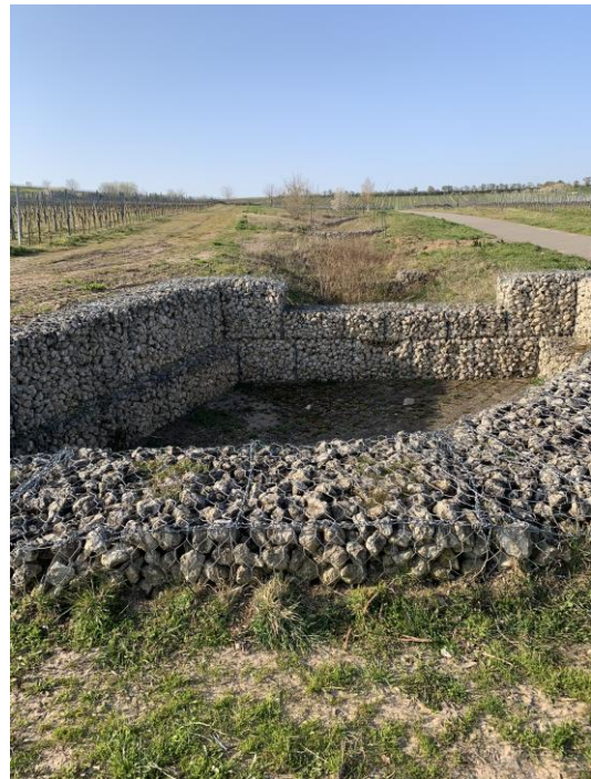
Abb. 57: Beispiele für straßen- und wegbegleitende Mulden (links mit aufgeschütteten Verwallungen, rechts mit Gabionen-Querdämmen (Fotos: Jessica Kempf)
