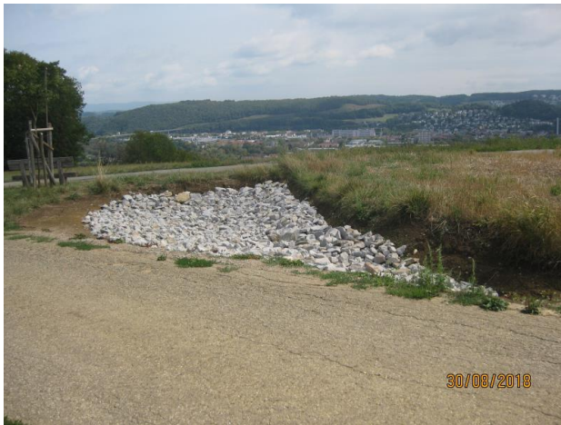
Abb. 56: Sickermulde in Lörrach-Tüllingen (Foto: Constanze Lehmann)
