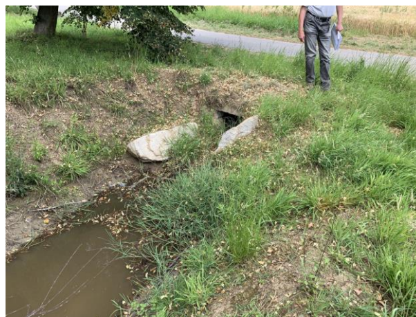
Abb. 51: Sedimentfangbecken in Schallbach (Foto: Jessica Kempf)
